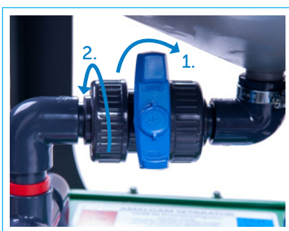
Bild. 5 Stäng spärrkranen och lossa överfallsmuttern
