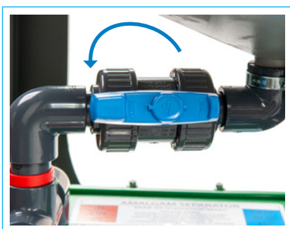
Bild. 52 Öppna spärrkranen
