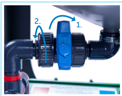
Bild. 43 Stäng spärrkranen
