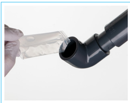
Bild. 49 Smörj in rörändar med fett
